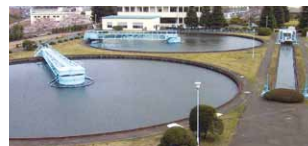
川崎市浄水所施設(沈殿池)
